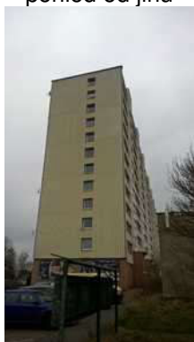
pohled od východu
