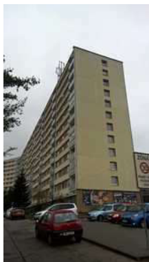
pohled od jihu
