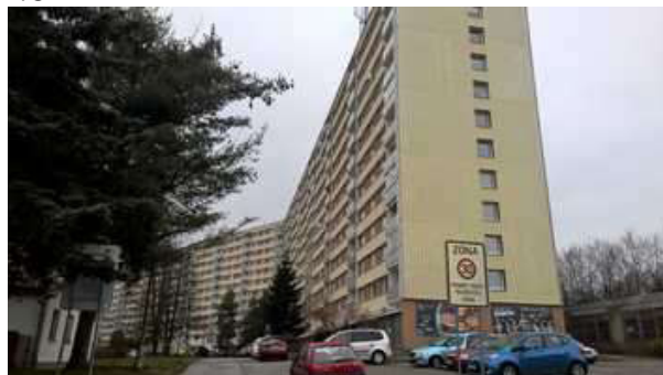
pohled od jihu
